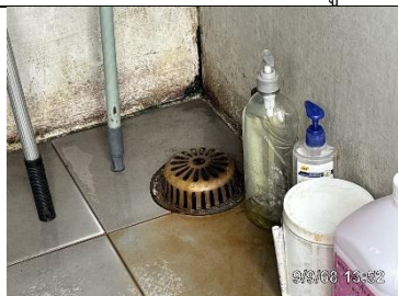
รูปที่ ผ7.58 ตะแกรงครอบตามรูท่อระบายน้ำทิ้ง
